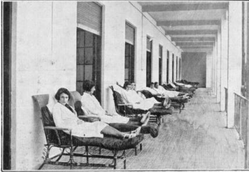
Fig. núm. 5 - Sanatorio de Andazarrate. Galería de cura
